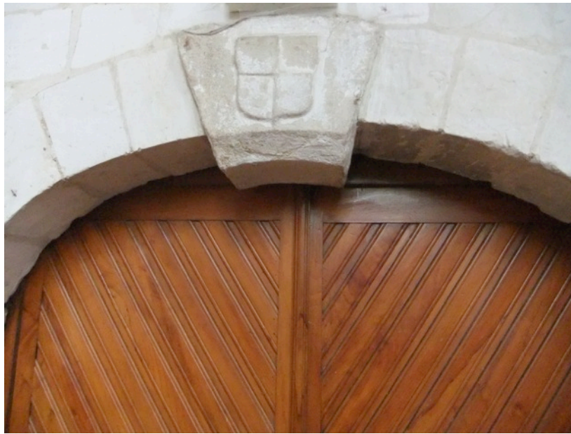
Écusson des Egmont au dessus de la porte du clocher.
